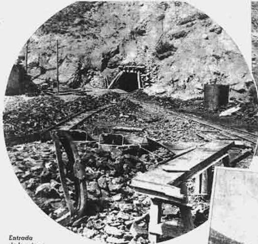
Entrada de la mina siniestrada
