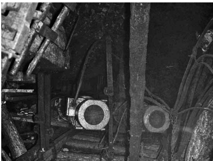
Detall del "Luneto", l'espai destinat a encabir-hi els motors i reductors del raspall i del panzer en el front de l'exploració. (ARXIU COMARCAL DEL BERGUEDÀ, FONS JOSEP DESEURAS, 04013050004245, 007)
