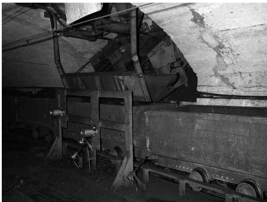
Les tremuges del pou de Santa Isabel situades al nivell Consolació, omplien el vagons. D'una capacitat de 1.750 litres, anomenats "Pegasos", que transportaran el producte cap a les instal·lacions del rentador situades, tal com 'ha comentat, a l'exterior de la mina, mitjançant la tracció d'una locomotora elèctrica. (ARXIU COMARCAL DEL BERGUEDA, FONTS JOSEP DESEURAS, 04013050004245, 006)
