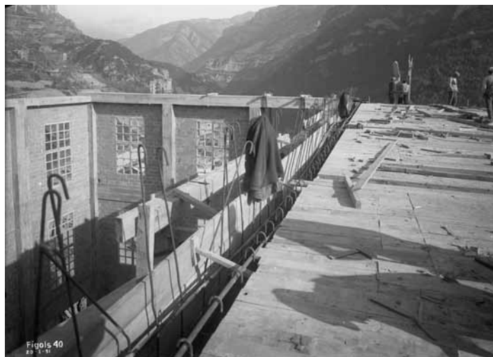
29 de gener de 1931. Els tancaments perimetrals de l'estructura de formigó de l'edifici de calderes; el de turbines i el de transformació ja estaven fets; es començava la coberta de l'edifici de calderes. (FONT. ANC- FONTS ANC1-211 / FUERZAS ELÉCTRICAS DE CATALUÑA, S.A (FECSA).214943-423596 I 214942- 423595).
