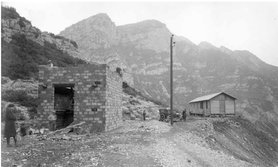
Inici de les obres d'esplanació. (FONT. ANC- FONTS ANC1-211 / FUERZAS ELÉCTRICAS DE CATALUÑA, S.A (FECSA). 214904.423557).
