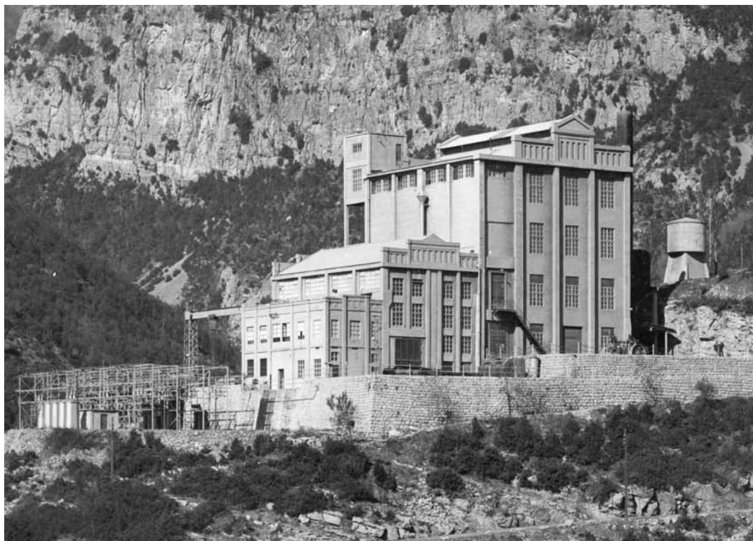
La central de Figols el 1944, després de les obres d'ampliació i millora.
